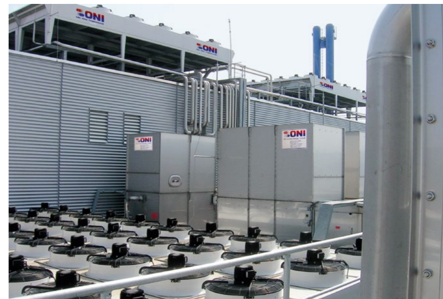
Komplexe, energieoptimierte Kühlanlage mit Wärmerückgewinnung für ein Unternehmen aus der Medizintechnik-Branche.
